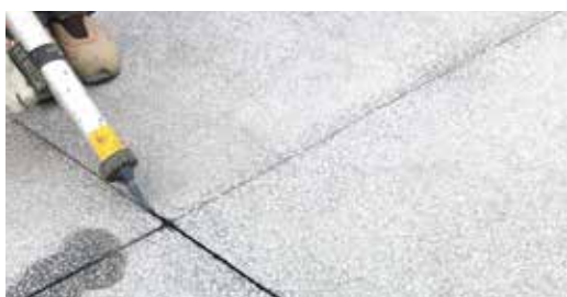
Sigillatura dei giunti con SIGILFLEX PU-M
