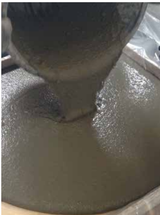
Figura 6 Movimentazione del materiale in cantiere
