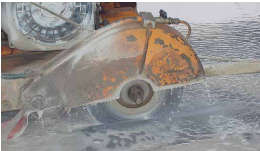
Foto 2 Taglio dei giunti di contrazione
