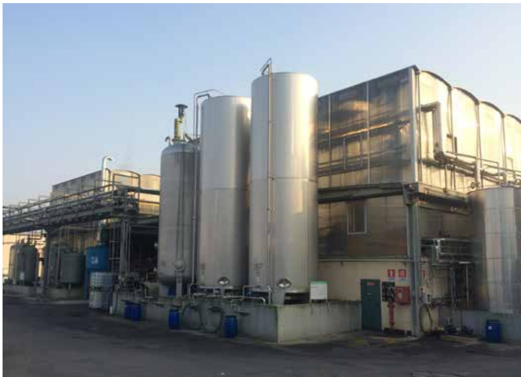
Impianto di produzione additivi
