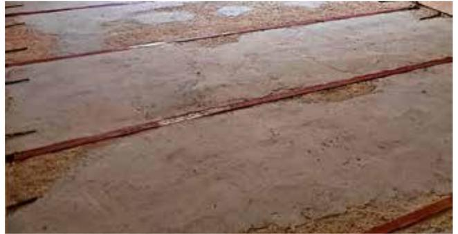
Rimozione della sovrastruttura e pulizia del supporto, con asportazione delle parti incoerenti e della polvere. Nel caso di solai con putrelle si procederà con la rimozione dell'eventuale ruggine superficiale.
