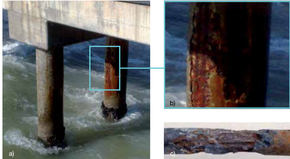
Figura 8 Corrosione delle armature nel calcestruzzo armato.
