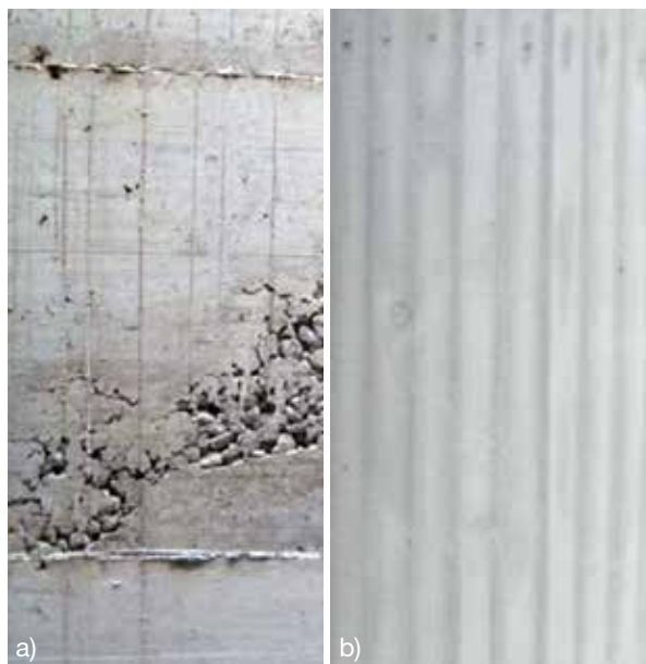
FIGURA 15 Risultato finale del getto di una miscela poco coesiva realizzata con solo cemento (a) e di una coesa e stabile realizzata con l'impiego di MICRO-POZZ PFA (b)
