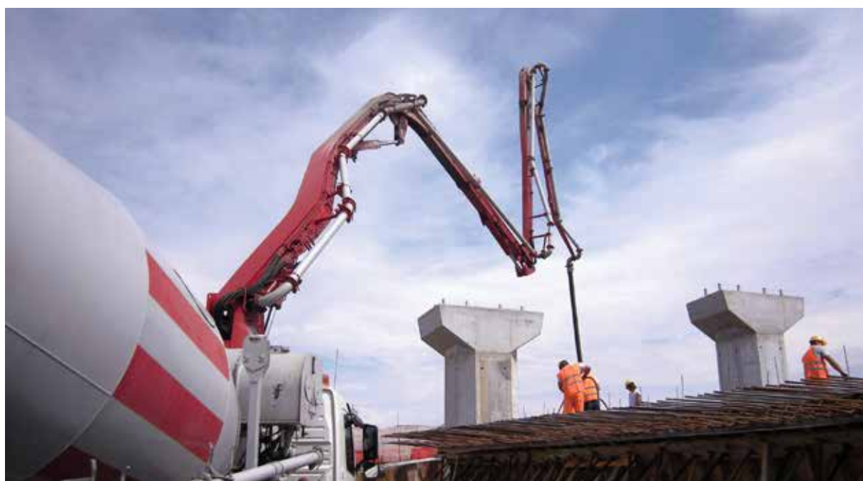
Calcestruzzo superfluido per impalcato autostradale
