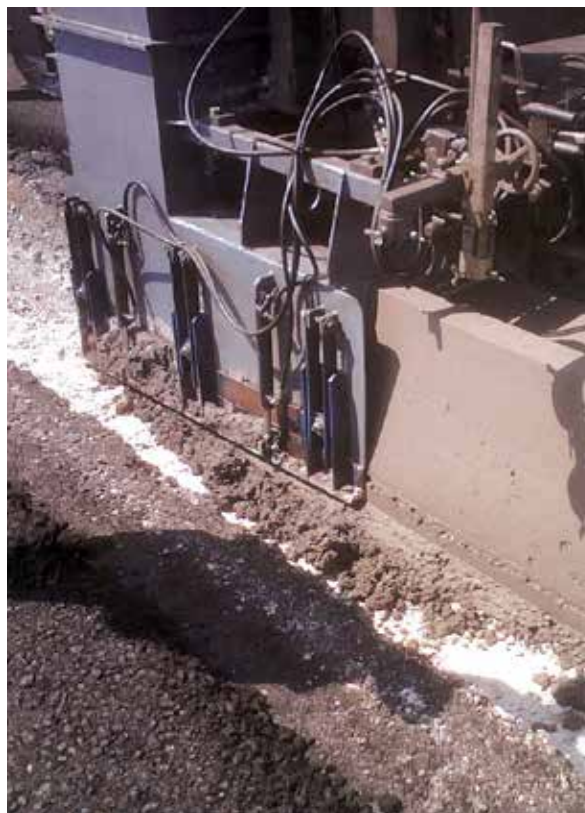
Applicazione in calcestruzzo estruso
