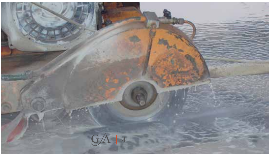
Foto 2 Taglio dei giunti di contrazione
