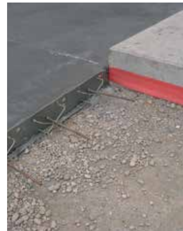
Foto 6 Giunto di costruzione (a sx) e di isolamento (a dx)
