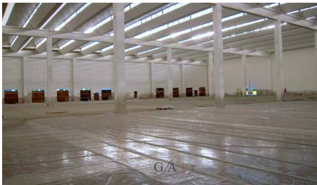
Foto 7 GiNIUS PAV, stagionatura con teli in polietilene
