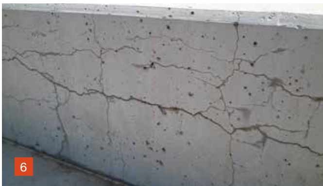
Figura 8 Degrado di una struttura in c.a. colpita da attacchi biologici
